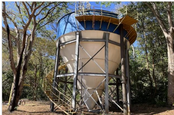
Figura 56. Unidades da ETE Pernada – (1) Reator UASB; (2) Floccodecantador
