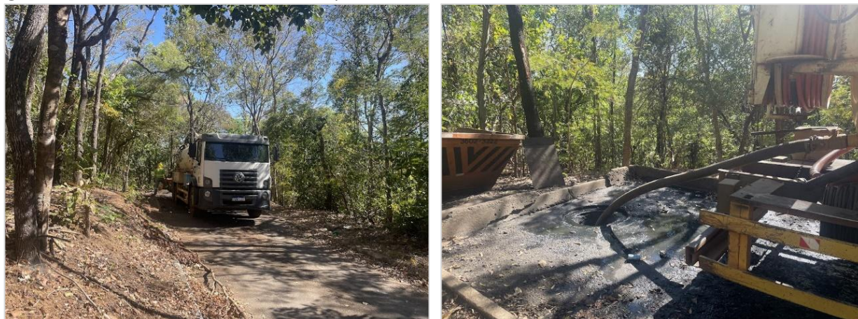
Figura 58. Recebimento de caminhão limpa fossa na área da ETE Pernada
