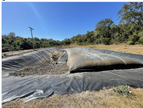
Figura 57. Valas sanitárias na ETE Pernada
