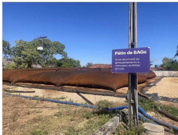
Figura 55. Algumas unidades da ETA 001 de Paraíso do Tocantins - (1) Tanque de lodo; (2) Sistema de desaguamento por BAG's
