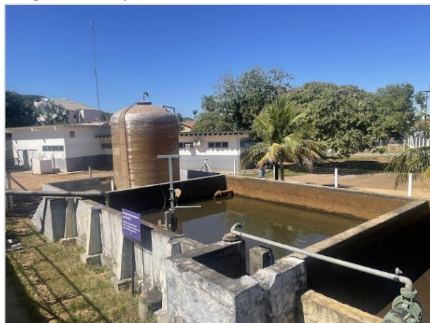
Figura 55. Algumas unidades da ETA 001 de Paraíso do Tocantins - (1) Tanque de lodo; (2) Sistema de desaguamento por BAG's
