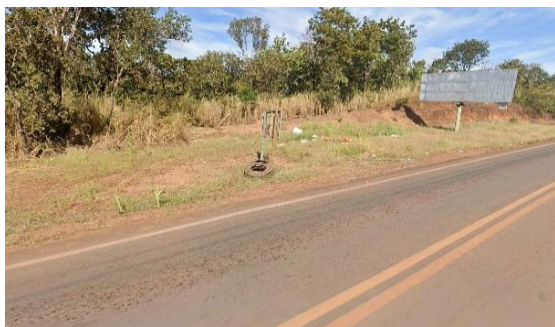
Ponto P162 – Rodovia TO-080 – Saída para Monte Santo
