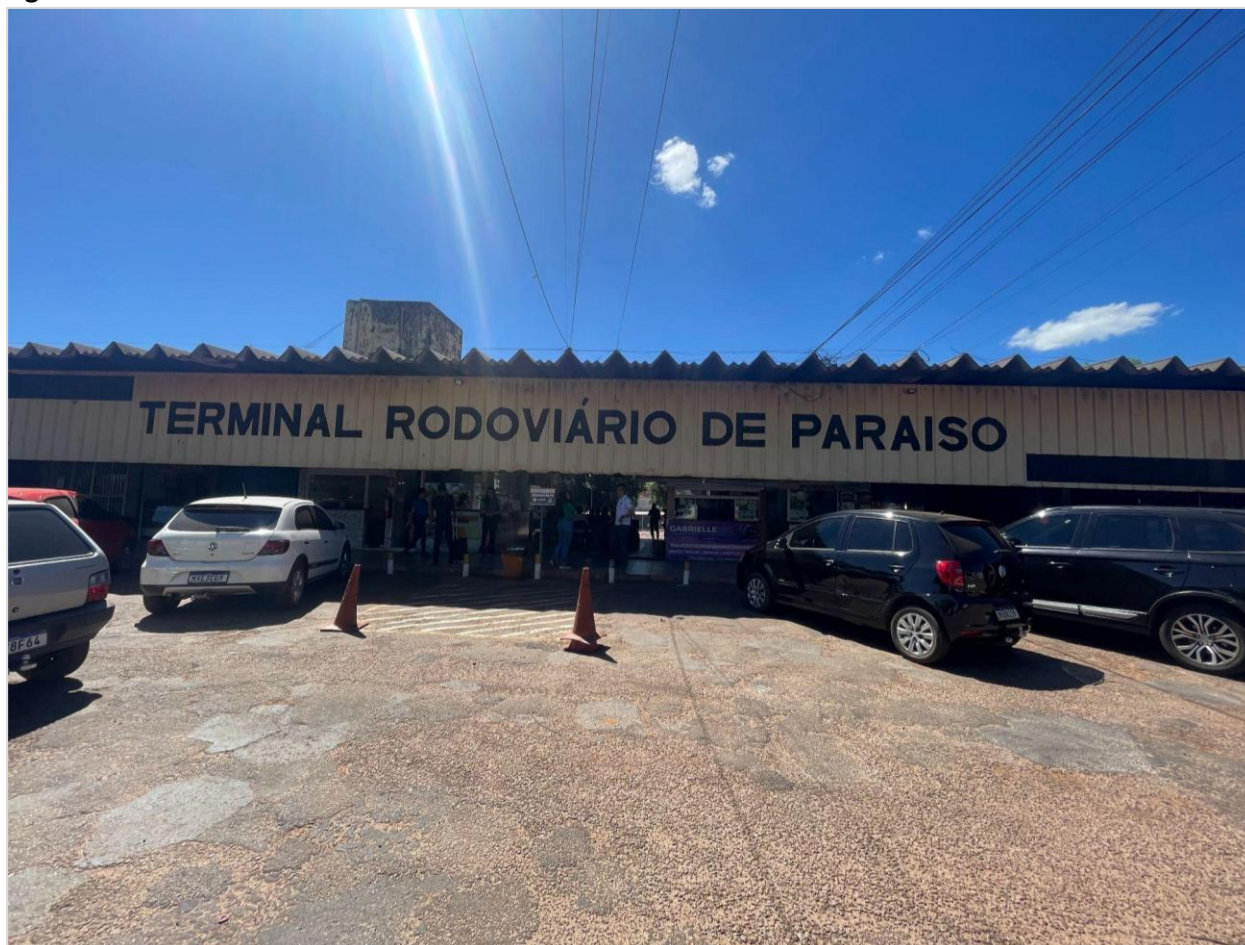
Figura 98. Terminal rodoviário de Paraíso do Tocantins
